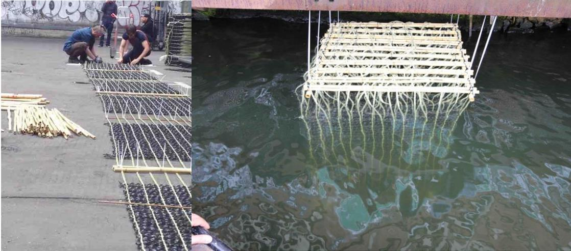
Abbildung 16: Vorbesiedlung der Muschelmatte in der Spree, Herstellung und Einbringung der Maten
